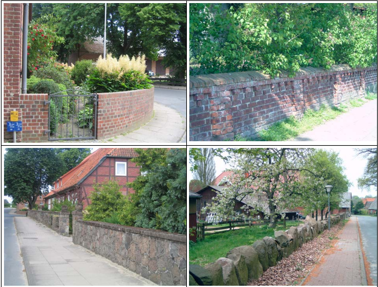
Beispiele für Grundstückseinfriedungen aus gemauertem Naturstein oder Ziegelsteinen entlang der Dorfstraße und nur aufgestellten Findlingen am Niendorfer Weg
