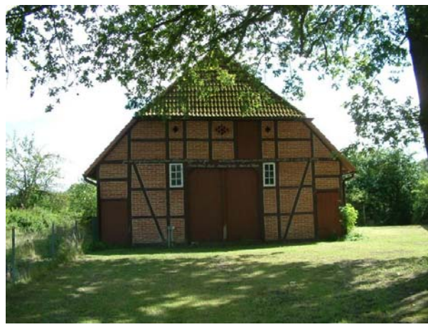
Birkenweg 16, Vierständerhaus, z. Zt. leerstehend
