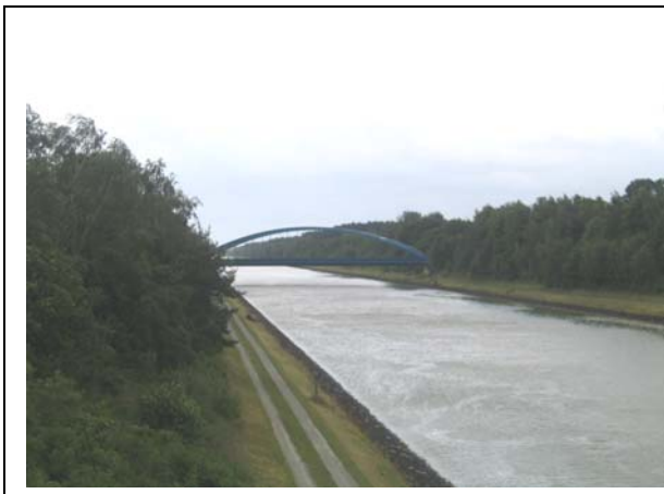
Elbe-Seitenkanal mit Eisenbahnbrücke östlich von Wendisch Evern
